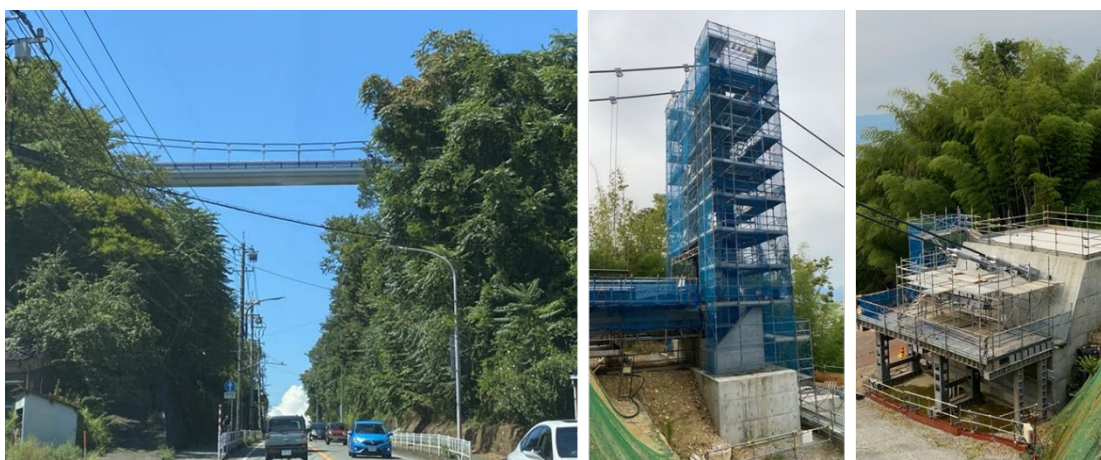
工事風景：令和 5 年 8 月
